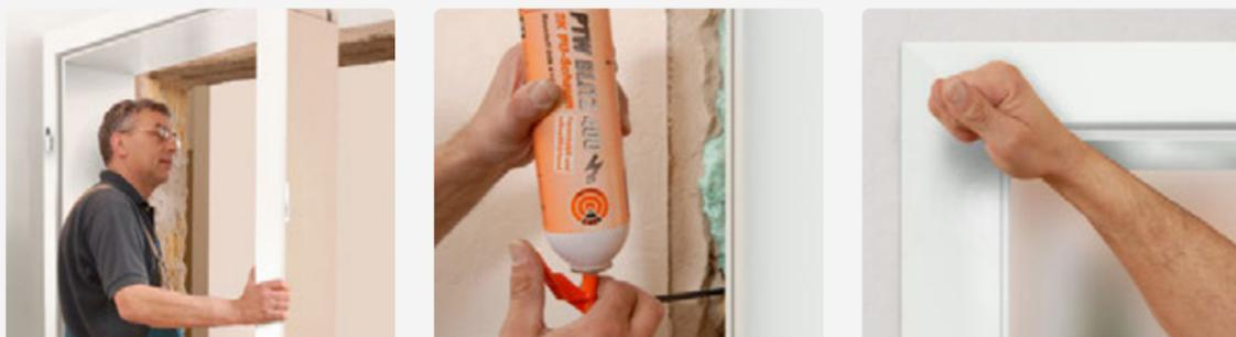
Nach dem Anpassen der Fußleiste an die neue Zargenbekleidung wird die auf Wunsch bereits im Werk zusammengebaute Zarge einfach in die Maueröffnung gestellt, ausgerichtet und mit Türspreizen fixiert. Mit speziellem Montageschaum wird die fachgerechte Montage fortgesetzt. Nach dem Aushärten des Montageschaums wird die Zierbekleidung eingesteckt, das neue Türblatt eingehängt und der Türdrücker aufgeschraubt – fertig!
