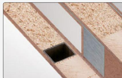
Klimaklasse III mit Stahlrohrverstärkung oder Aluminiumverbundabsperung
